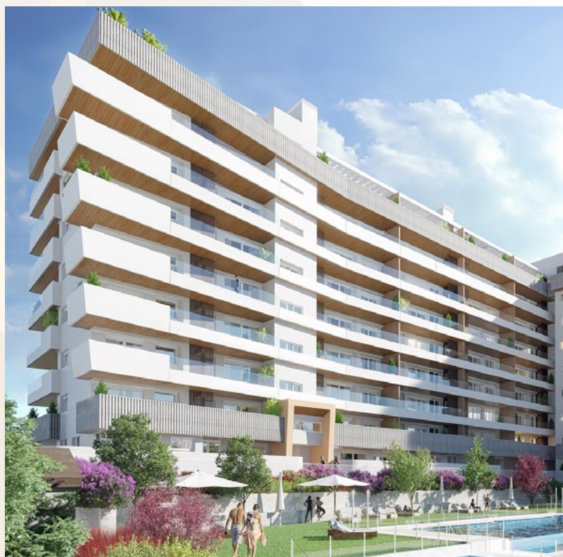
Edificio de viviendas en Tres Cantos, Madrid.
