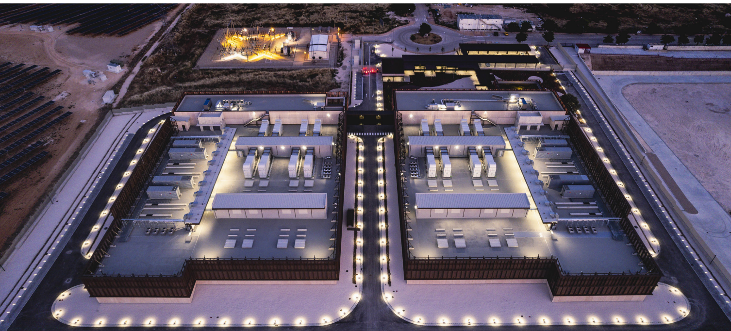
Centro de procesamiento de datos ejecutado por FCC Construcción.
